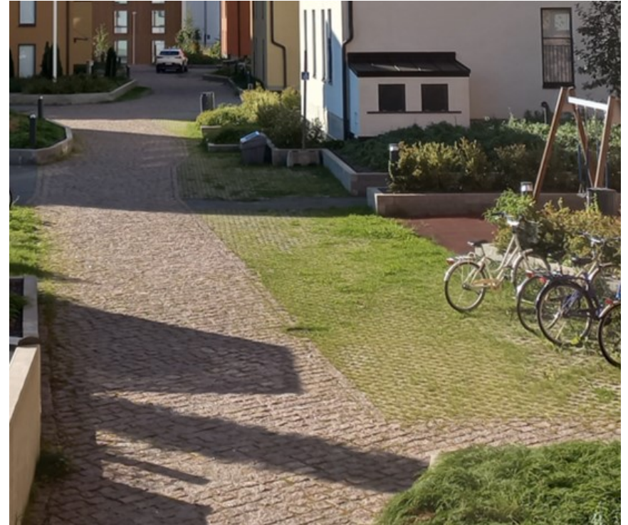
Vettä läpäiseviä pintamateriaaleja pihalla. Kuva Tampereen kaupunki.
