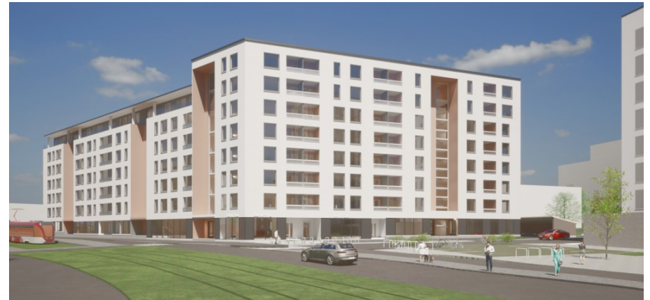
Viitesuunnitelman havainnekuva idästä kohti eteläosan rakennuksen kulmaa, Reilers Oy
