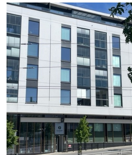
Sisäänvedettyjä parvekkeita kadun puolella. Ikkunat ovat päällekkäin ja niiden väliset värikentät on sijoitettu selkeästi. Kuva: Tampereen kaupunki.
