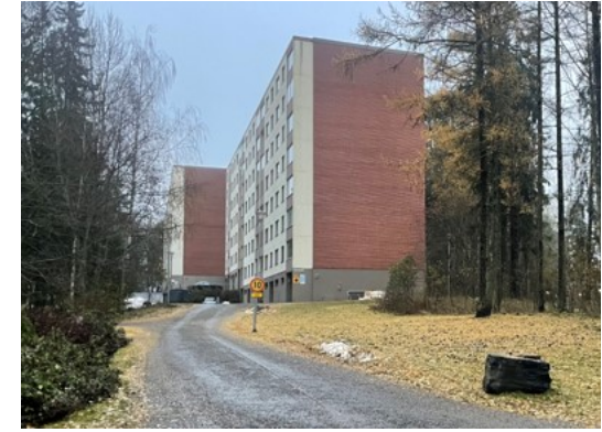
Tiilipinnat säilytetään julkisivukorjauksissa. Kuva: Tampereen kaupunki.
